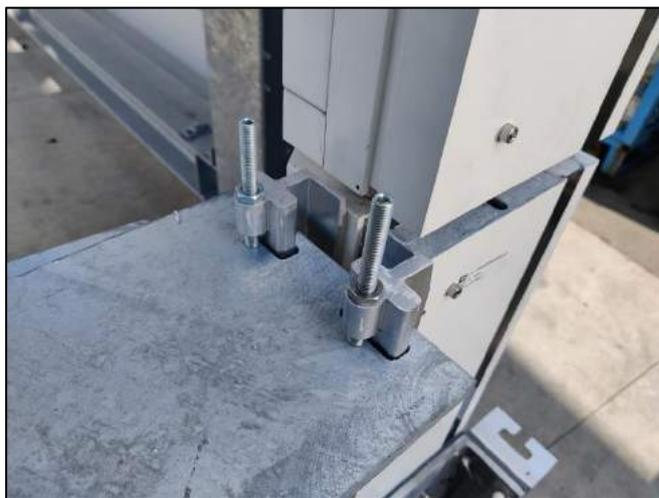
*figura 2.47 – Blocchetti e staffe di collegamento cellule "units" – struttura*
