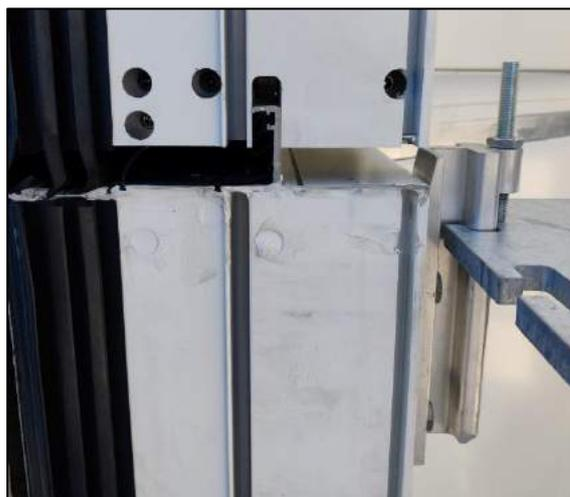
*figura 2.48 – Giunto maschio – femmina e vista laterale del blocchetto*
