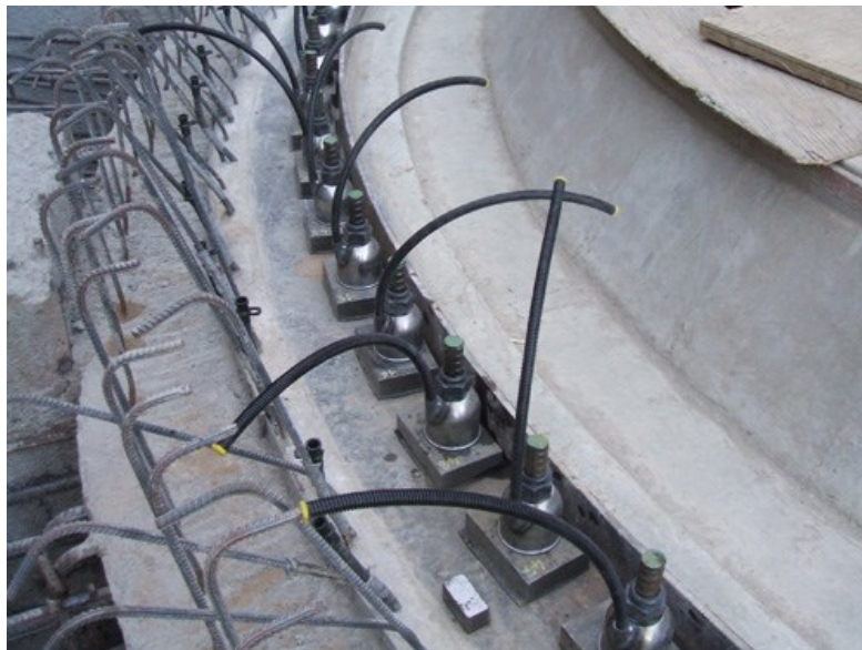
Figura 55: Post-Tensione a barre DYWIDAG.
