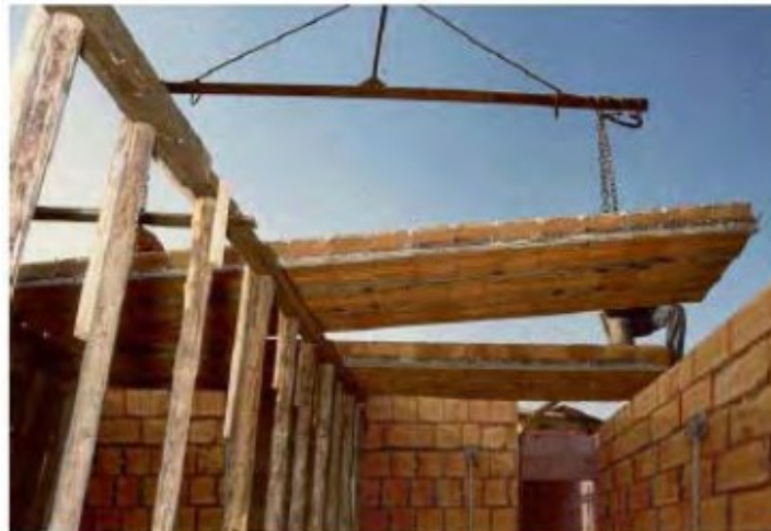
Figura 11: Solaio a pannelli prefabbricati: fase di posa in opera.
