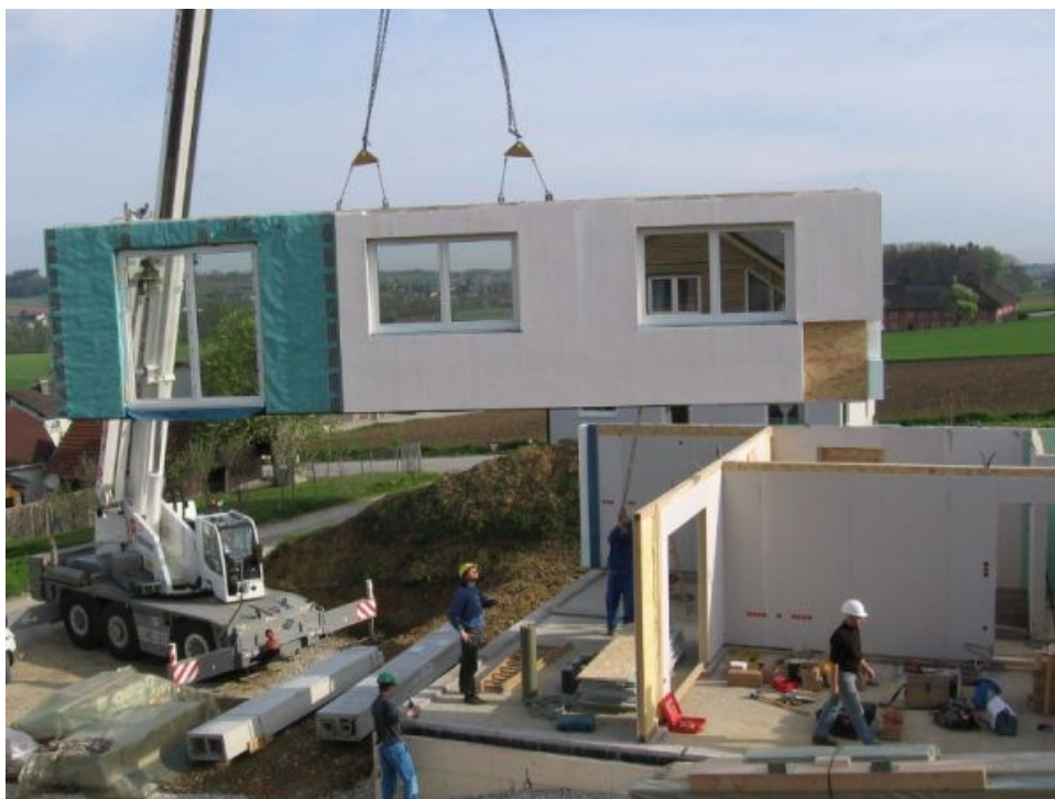
Figura 18. Prefabbricazione leggera in legno: assemblaggio a secco delle pareti autoportanti in cantiere.
