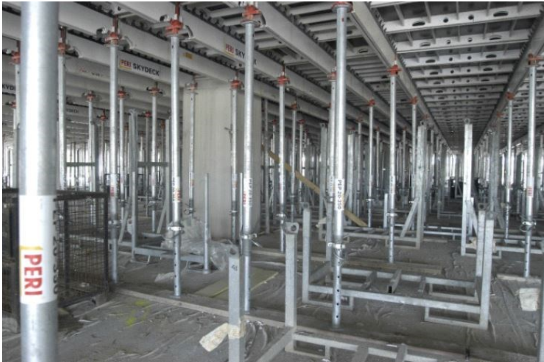
Figura 61: Centro commerciale Auchan a Cinisello Balsamo; particolare della cassetta per il getto della soletta.
