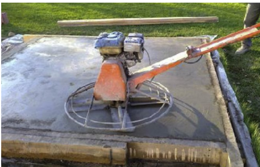
Figura 2.5-2: Realizzazione di una pavimentazione industriale in calcestruzzo di scorie EAF
