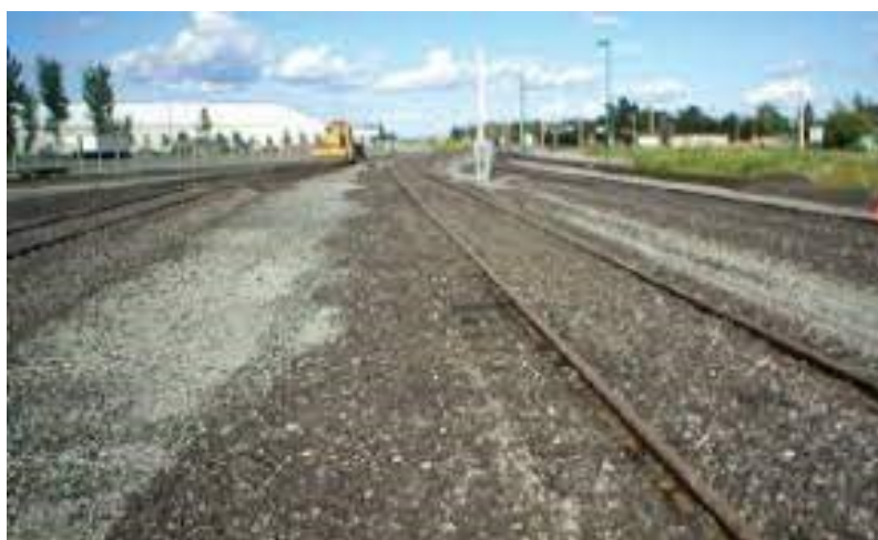
Figura 2.5-1: Esempio di utilizzo di scorie EAF nell'ambito delle costruzioni ferroviarie
