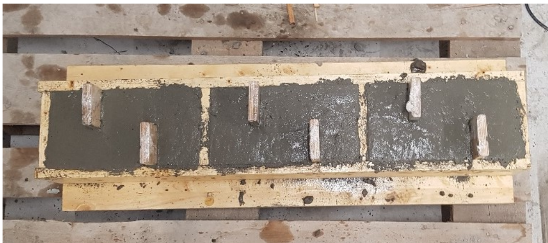
Figura 6.4-2: Il calcestruzzo fresco all'interno del cassero
