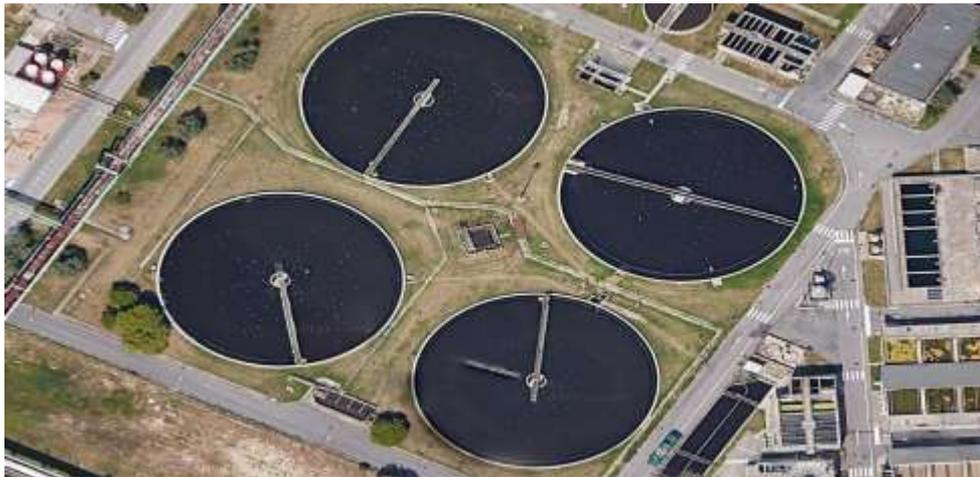
**Finalità:** Rispettare i limiti di legge relativi ai solidi sospesi nell'effluente e mantenere nelle vasche di denitrificazione e nitrificazione ad un valore di solidi sospesi costanti ( fango attivo).
