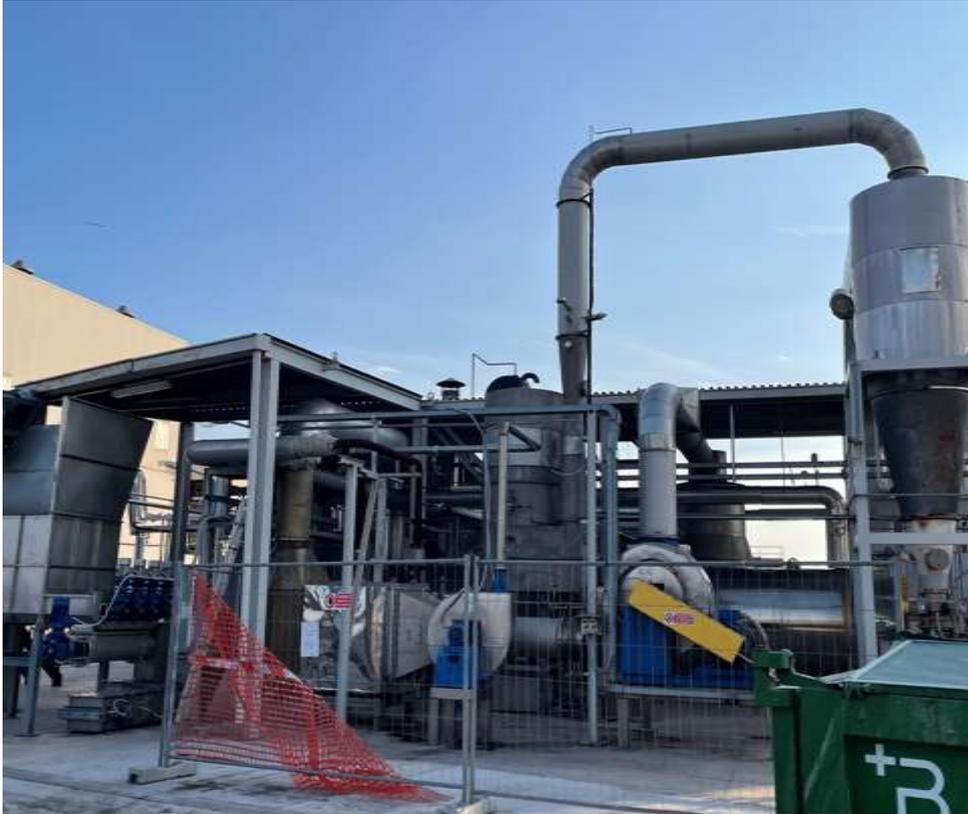
**Scopo della sezione:** rimuovere l'acqua dai fanghi già disidratati
