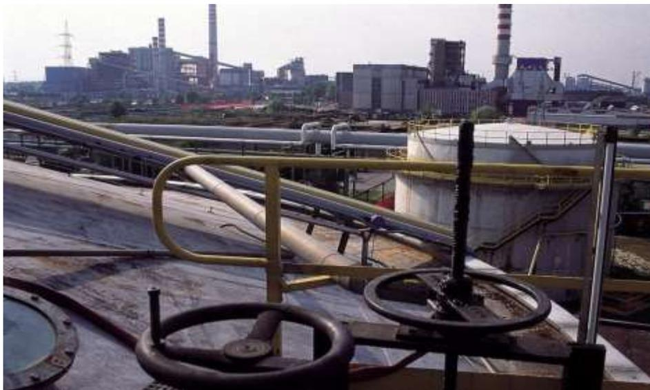
***Digestori fanghi - digestione anaerobica mesofila ( 3300 mc ciascuno)***
