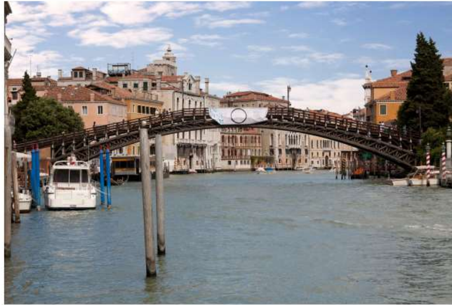
Foto dello stato attuale del ponte vista verso Cà Foscari
