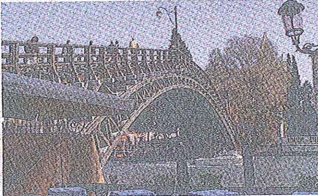
Il ponte in legno dell'Accademia è spesso soggetto a principi d'incendio
