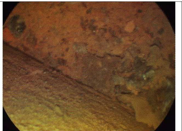
Fig. 8: ruggine e sfogliatura in un angolo
