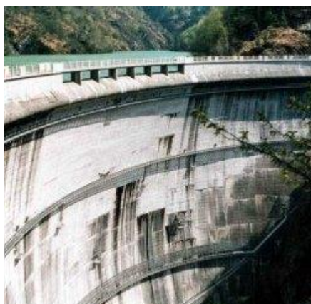
Figura 5. Diga di Val Gallina. Sx: Foto del coronamento e del ciglio sfiorante ; Dx: tavole di sviluppo longitudinale e sezione maestra
