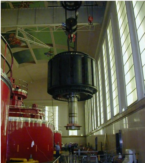
Figura 4. Movimentazione del rotore dell'alternatore
