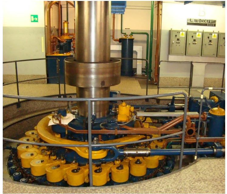
Figura 5. Meccanismo di comando del distributore
