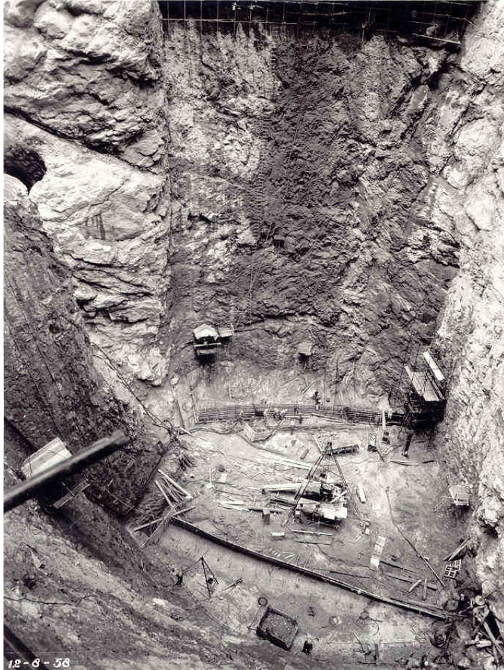
Lavori in fondazione diga
