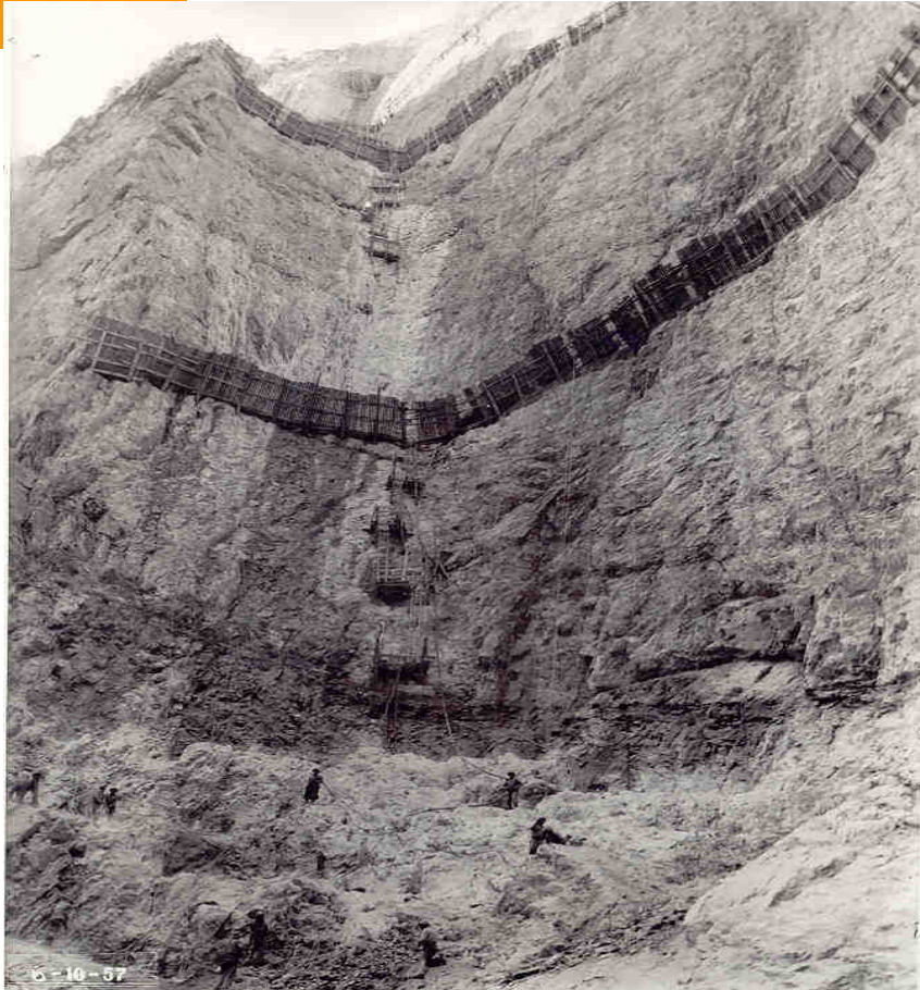
Preparazione imposta spalla dx
