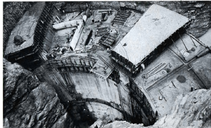
1. Costruzione della diga. Giunto suborizzontale a q. 510 (novembre 1958)
