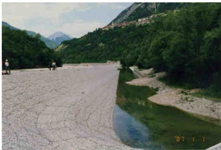
Soglia di scarico a quota 640 verso torrente Cimoliana Evidente il forte inghiaioamento dell'imbocco
