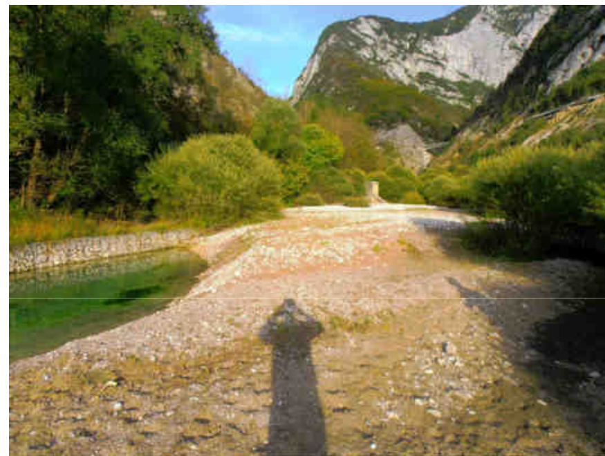
Soglia di scarico a quota 640 verso torrente Cimoliana Evidente il forte inghiaioamento dell'imbocco
