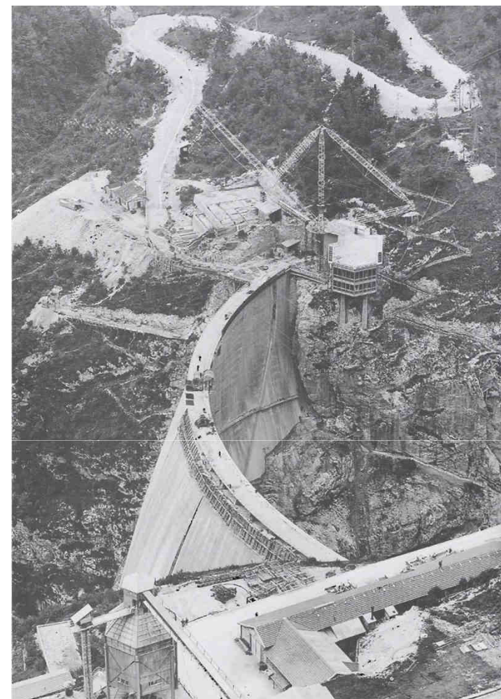
Diga quasi completata, con cabina comandi Derrick e strada verso il pian del Toc (estate 1960)
