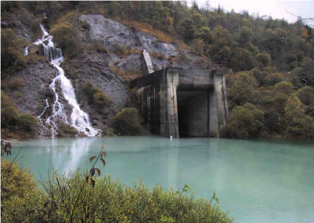
Soglia di scarico a quota 635 – imbocco galleria ex bypass verso Piave
