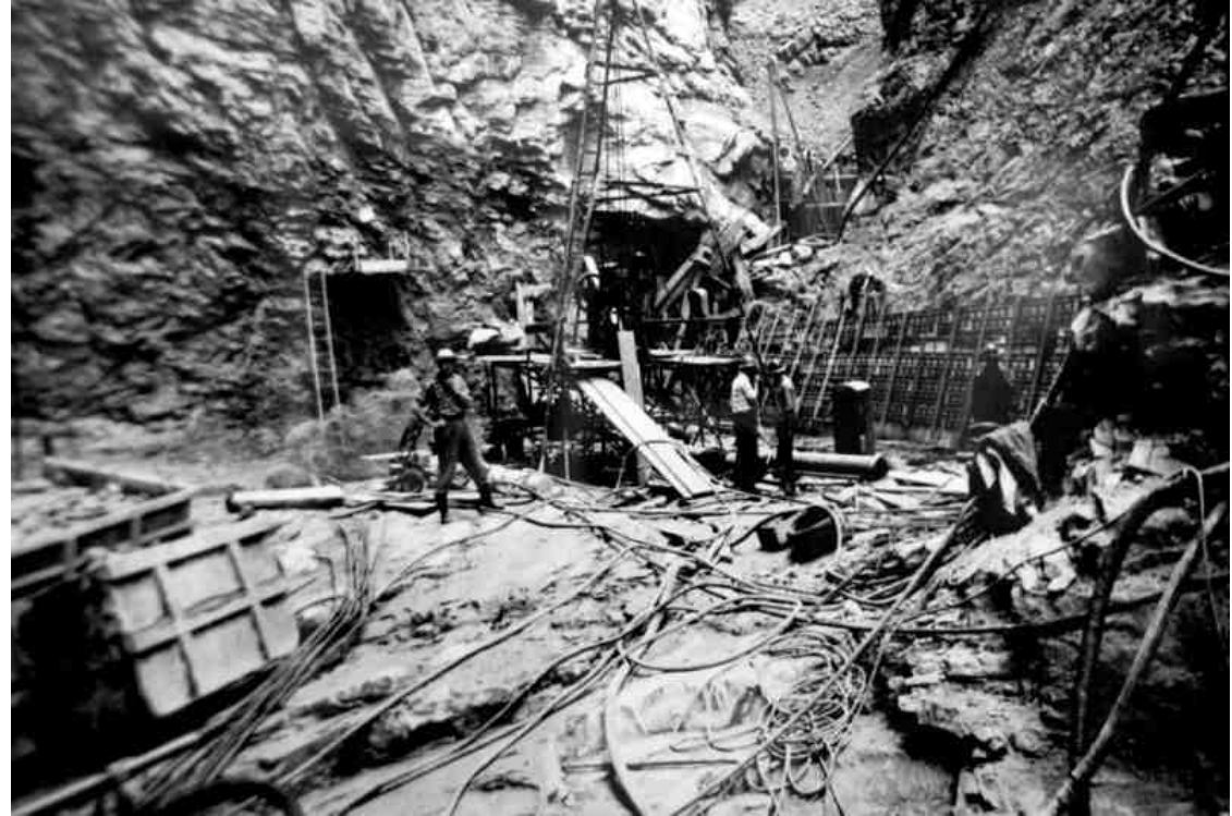
Lavori in fondazione diga preparazione del piano d'imposta
