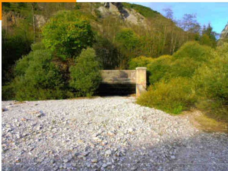
Soglia di scarico a quota 640 verso torrente Cimoliana Evidente il forte inghiaioamento dell'imbocco
