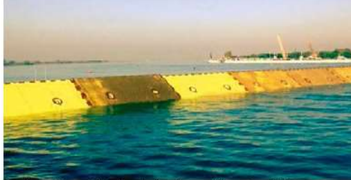
Fig. 2 - Il MOSE Lido-Treponti: schiere di paratoie sollevate durante una delle recenti prove di funzionamento (Fonte: Consorzio Venezia Nuova)
