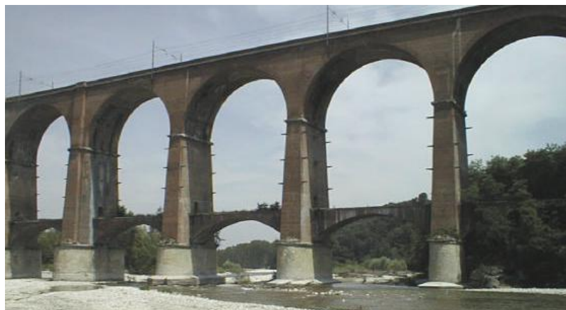
Figura 1.7 Viadotto Stura – Linea Fossano-Ceva, progressiva 2+606. [8]
