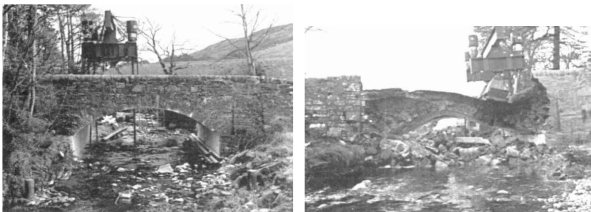
Figura 3.11 Shinafoot Bridge : prospetto ovest (a sinistra) e condizione del prospetto ad est poco prima del collasso (a destra). [48]
