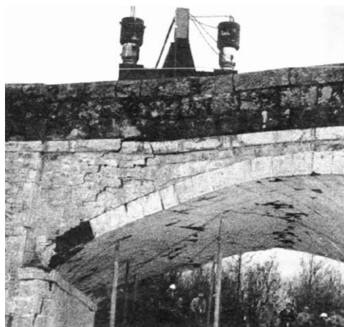
Figura 3.13 Barlae Bridge : prospetto sud-est (a sinistra), formazione di tre cerniere durante l'applicazione del carico (a destra). [49]
