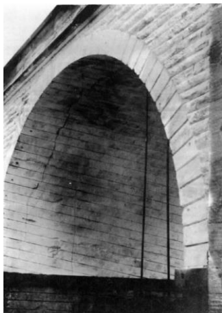
Figura 3.7 Bargower Bridge : prospetto (in alto a sinistra), sezione longitudinale e trasversale con le principali indicazioni geometriche (in alto a destra), fessurazione longitudinale preesistente nell'arcata (in basso a sinistra) e condizione a collasso (in basso a destra). [54]
