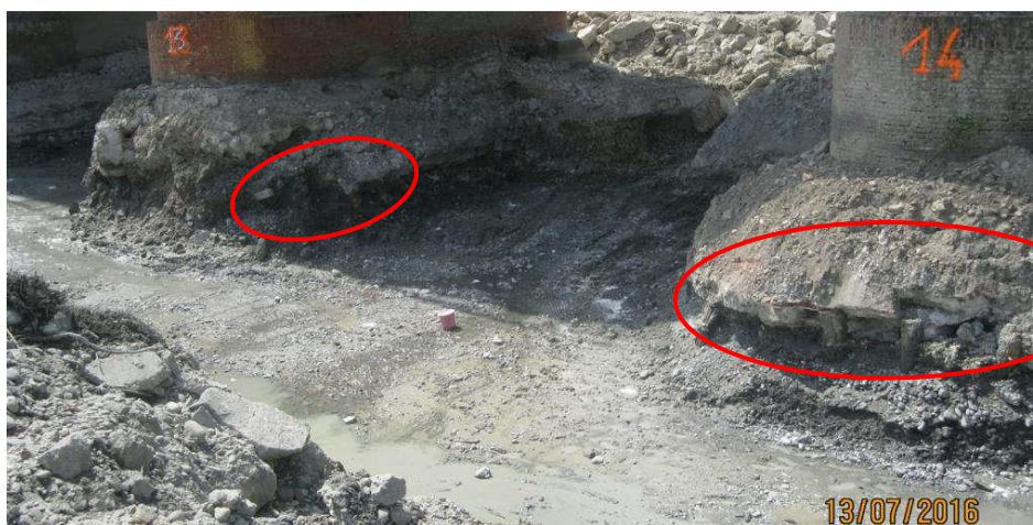
Figura 5.21 Foto realizzata il 13/07/2016 durante la realizzazione delle opere del I lotto in corrispondenza della porzione di valle delle pile 13 e 14. [178]
