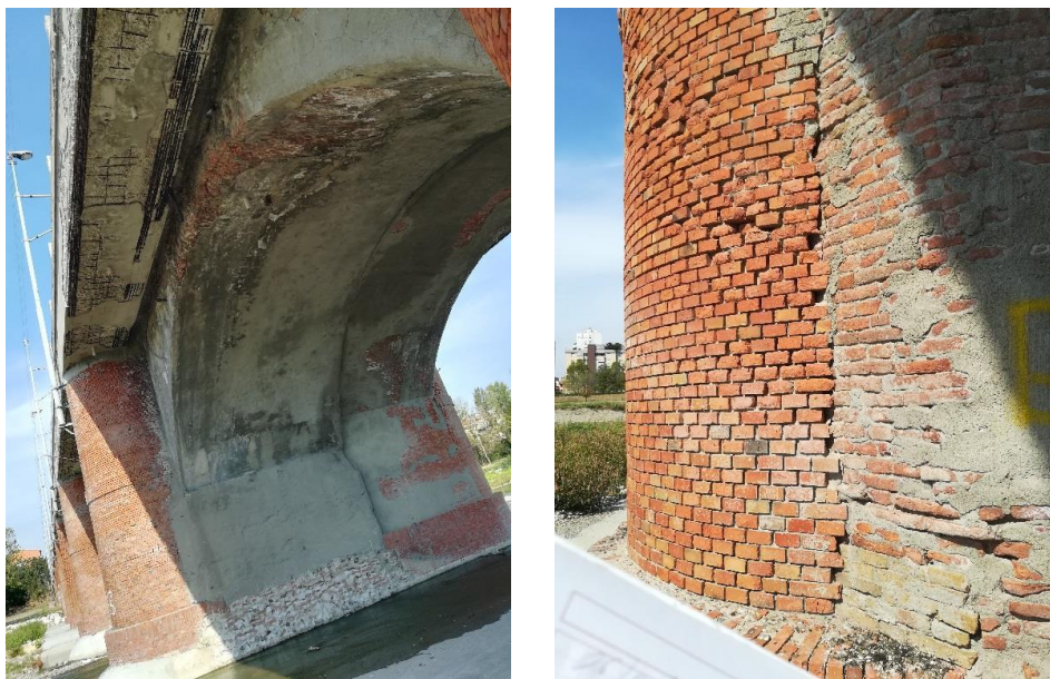
Figura 5.16 Vista dal basso di lato a monte (sud) dell'arcata numero 5 (a sinistra) e dettaglio della muratura di rivestimento dei rostri semicircolari (a destra). Nella foto a sinistra è evidente il dislivello tra parte di valle e monte e l'avanzato stato di deterioramento del manufatto in cemento armato. [25]
