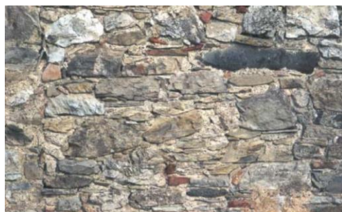
Figura 2.2 Muratura in blocchi di pietra sbozzata. [20]
