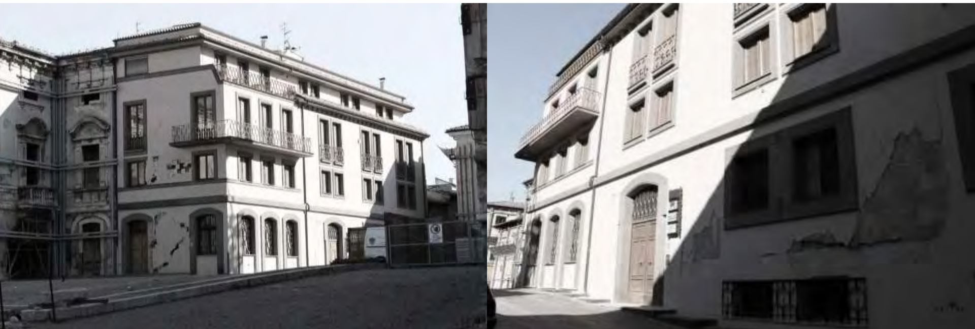
Situazione post sisma 2009
