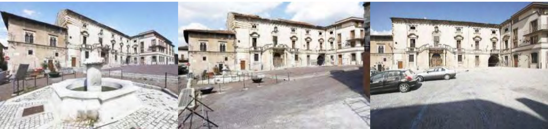
Situazione post sisma 2009
