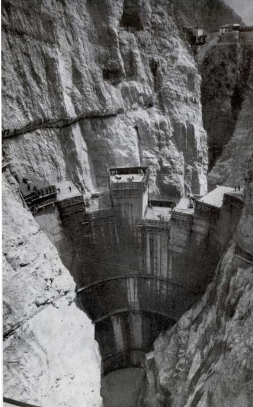
8. Stato di avanzamento della diga nel maggio 1959 - Vista da valle
