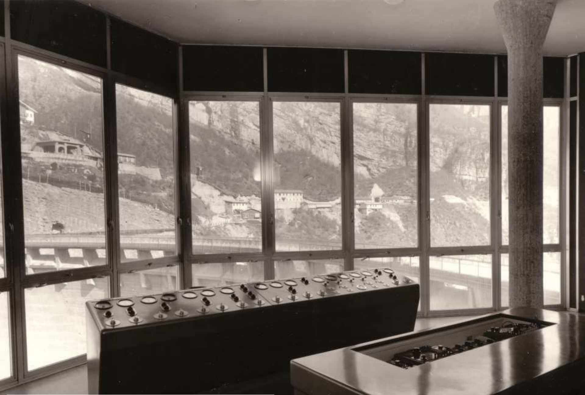
Sala controllo della diga
