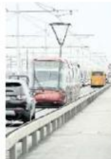
MONITORATO Il ponte della Libertà
