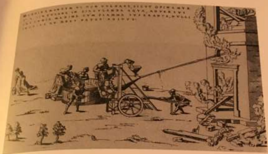
In alto: Illustrazio- di una pompa idra- tratta dal Theatra instrumentorum e machinarum di Je- Besson, Lione 17
