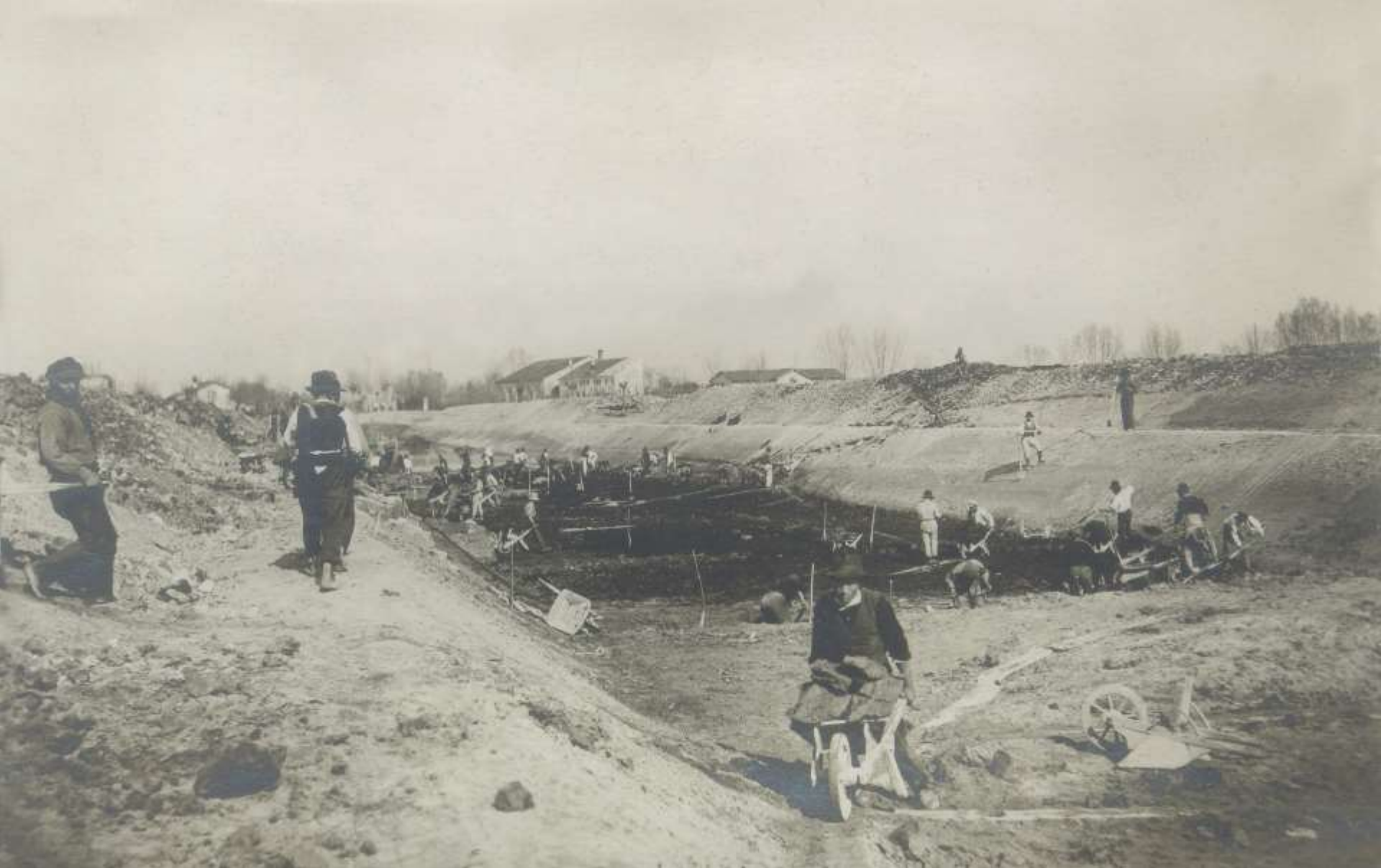
SCAVO CANALE BARBEGARA IN COMUNE DI CANDIANA
