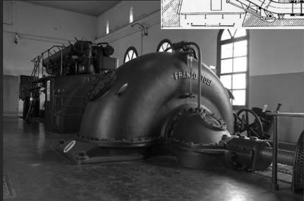
Sala Macchine – Turbine Franco Tosi (1935) – Idrovora Vampadore
