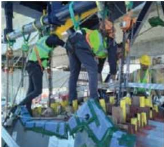
(d) Insertion into tower saddle
