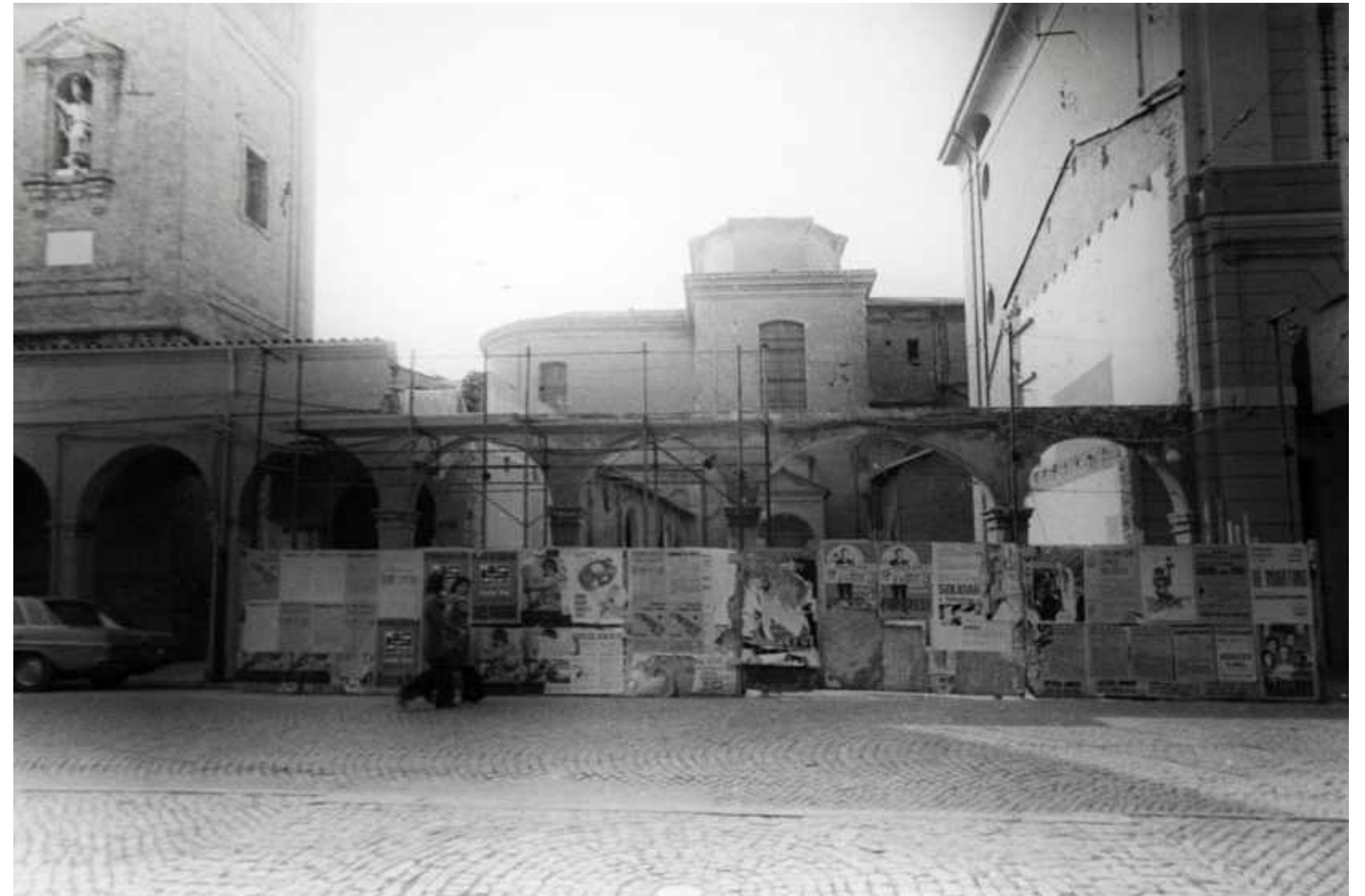
abbattimento edificio precedente 1974
