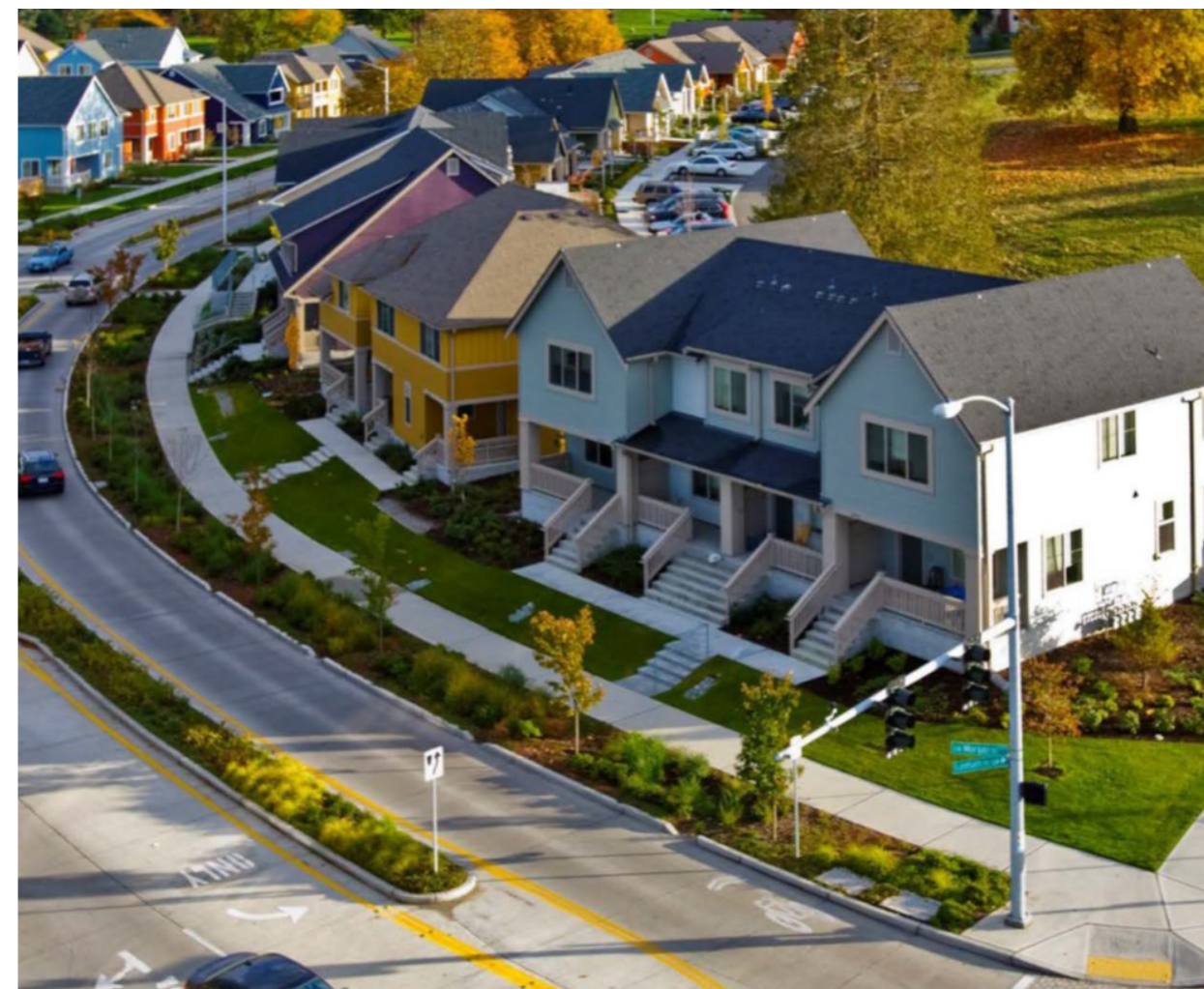
Figura 19 – Bioretention lungo il bordo stradale di Sylvan Way, Seattle ( Seattle GSI Manual, volume III ).
