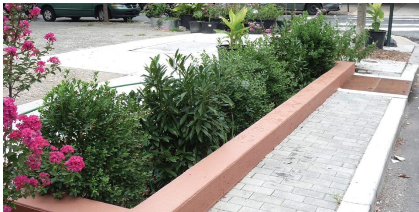
Figura 8 - Stormwater Planter in Columbus Square, Philadelphia (PA, USA) (a sinistra). In basso sono riportati due tipologie, rispettivamente Infiltration Planter (a sinistra) in cui l'acqua piovana trattata viene infiltrata nel terreno direttamente in falda, e Flow-Through Planter (a destra) in cui l'acqua infiltrata viene scaricata in un tradizionale sistema di drenaggio delle acque piovane. Sono in genere composti da uno strato di terreno organico in cui vengono piantumate le specie vegetali, e uno strato di pietrame che permettono la filtrazione dell'acqua piovana. Sono inoltre provvisti di un troppo pieno in modo tale che l'acqua piovana in eccedenza, che non riesce ad essere filtrata, viene scaricata nel sistema fognario.
