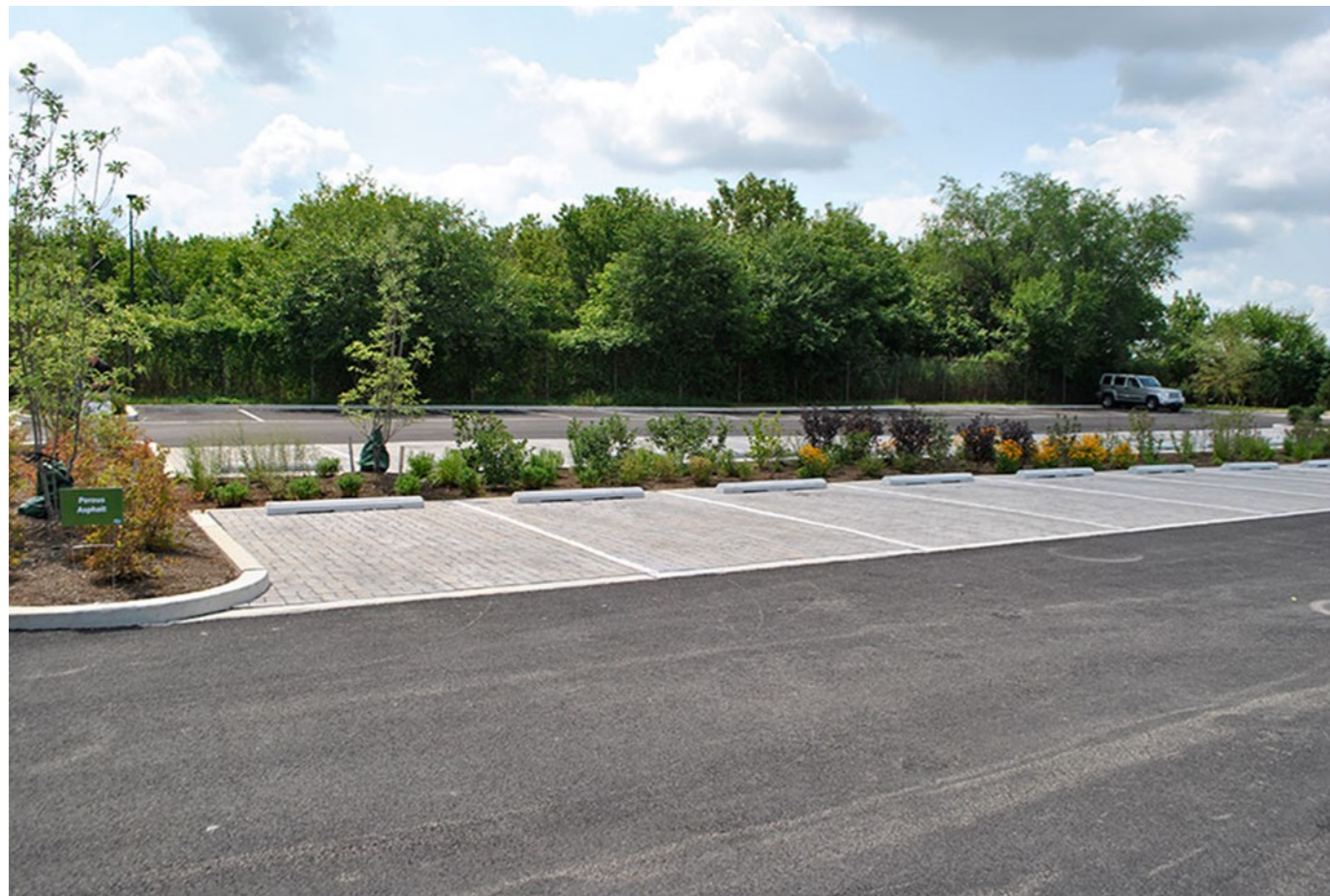
Figura 7 – Permeable Pavement in uno spazio adibito a parcheggio in Philadelphia (PA, USA) (sinistra). Le pavimentazioni permeabili si distinguono in: a) Permeable Pavers ; b) Porous Concrete ; c) Porous Asphalt (a destra). In conformità con l' American Society of Testing and Materials (ASTM) , in base alle tre tipologie dispone che:
