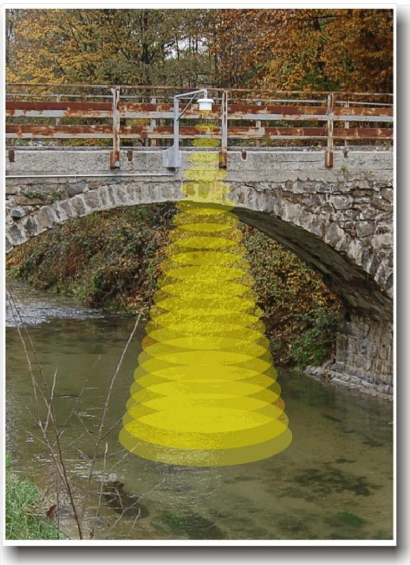
**di cui 70 con sensore di livello ad ultrasuoni**
